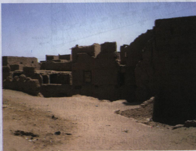
Qsar intra muros en ruine
